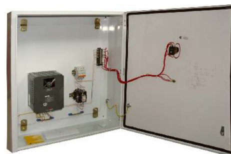
ЩУ Узла (Щит частотного регулирования привода)
